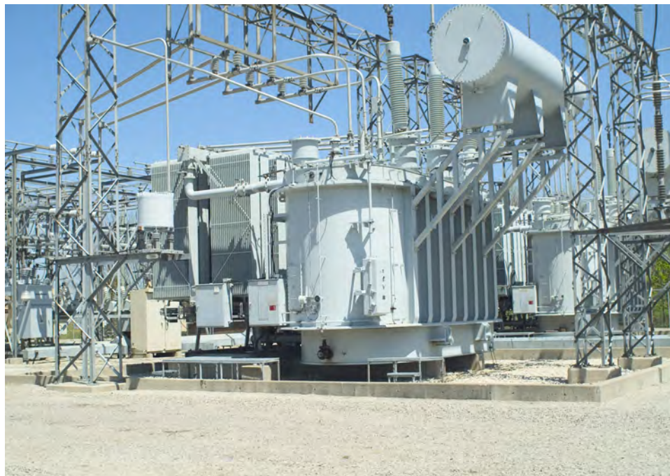
Banco trifásico de transformadores utilizado para distribución de energía.
